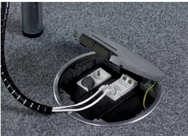
Abb.3: MICROSENS Gigabit Micro-Switch eingebaut im Bodentank
