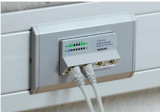
Abb. 2: MICROSENS Gigabit Micro-Switch eingebaut im Kabelkanal
