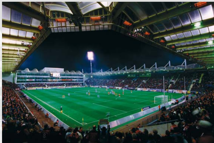
Abb.1 Strahlerinstallation in der BayArena
