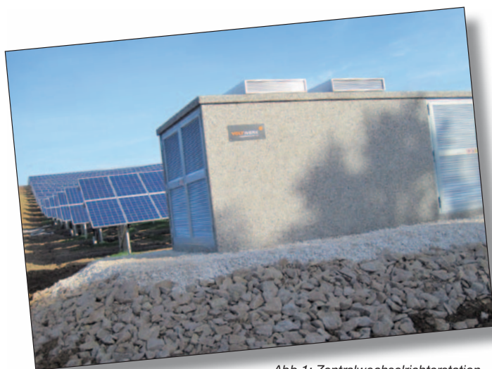
Abb.1: Zentralwechselrichterstation
