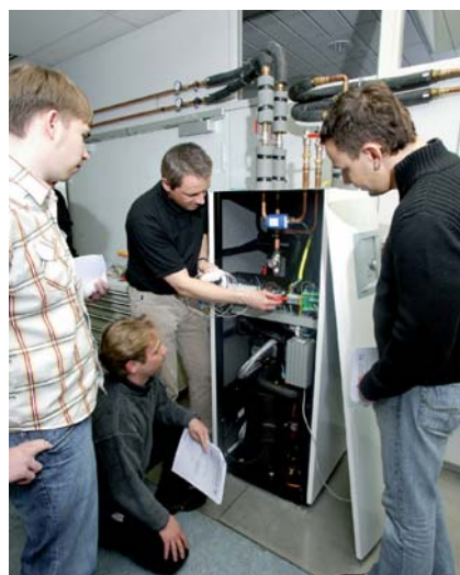
Abb.10 Bei der Produktschulung „Wärmepumpe“ arbeiten die teilnehmenden Installateure in kleinen Gruppen am Gerät
