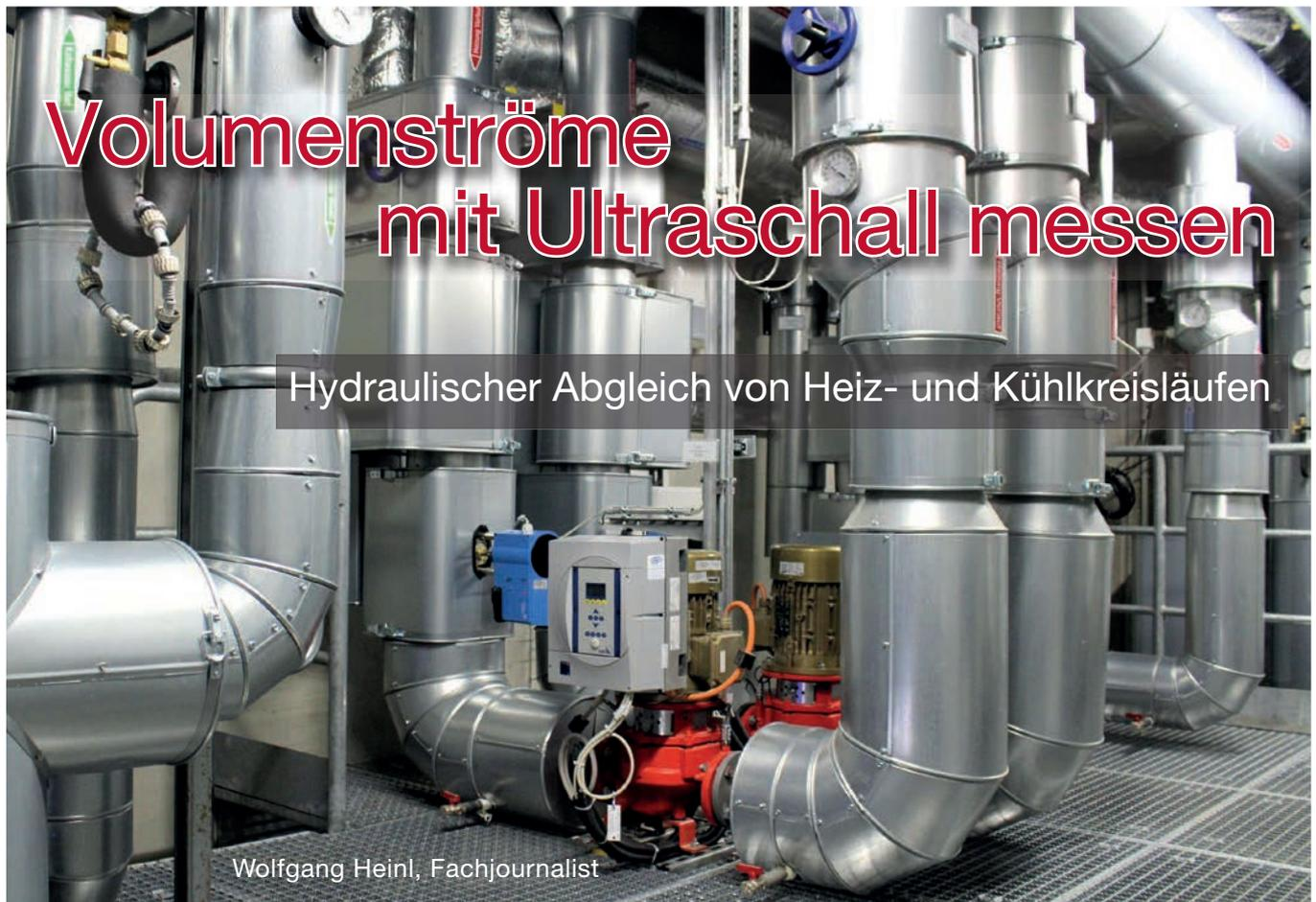
Abb.1: Der hydraulische Abgleich von Heiz- und Kühlkreisläufen in größeren Anlagen erfordert neben Armaturen zur Einregulierung auch die Möglichkeit zur Kontrolle der Ist-Volumenströme.
