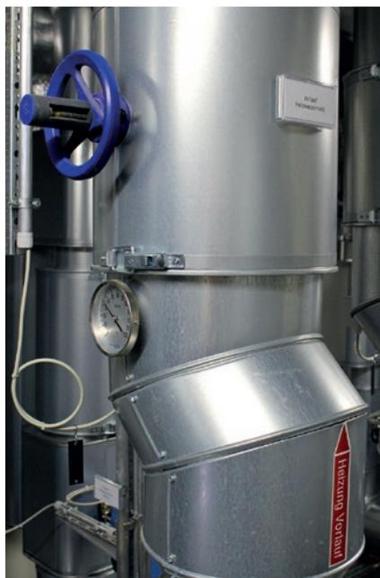
Abb.5: Die Gehäuseform des Mess- und Regelventils BOA-Control ermöglicht eine einfache Ausführung bei der Armaturendämmung.
