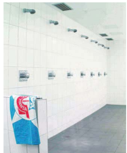
Abb. 4b Vandalen bekommen bei diesem Brausekopf von Aqua-Rotter allenfalls eine „kalte Dusche“. Das Gehäuse hat eine für unbefugte Personen nicht zugängliche Verschraubung
