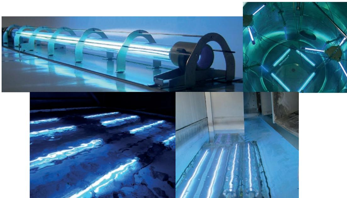
Abb. 1: In Kühltürmen installierte UV-Strahler vom Typ Microfloat® & Microspear®
