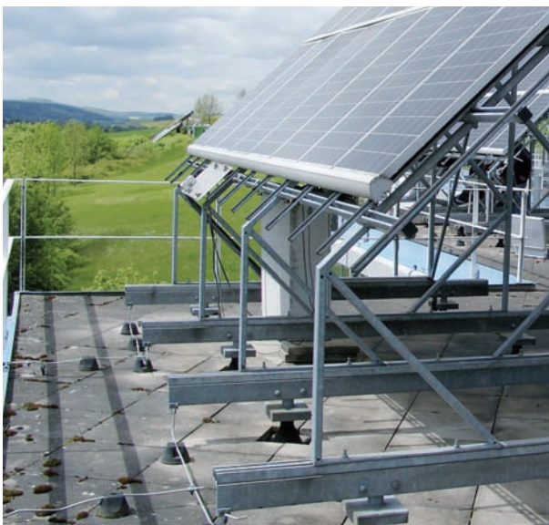
Abb.4 / Abb.5 Anschluss der Tragekonstruktion mit einem Leiter-Querschnitt von circa 16 mm 2 (links) an den Potentialausgleich – Auch Metallrahmen müssen elektrisch leitend miteinander verbunden werden (rechts).
