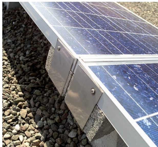
Abb.4 / Abb.5 Anschluss der Tragekonstruktion mit einem Leiter-Querschnitt von circa 16 mm 2 (links) an den Potentialausgleich – Auch Metallrahmen müssen elektrisch leitend miteinander verbunden werden (rechts).
