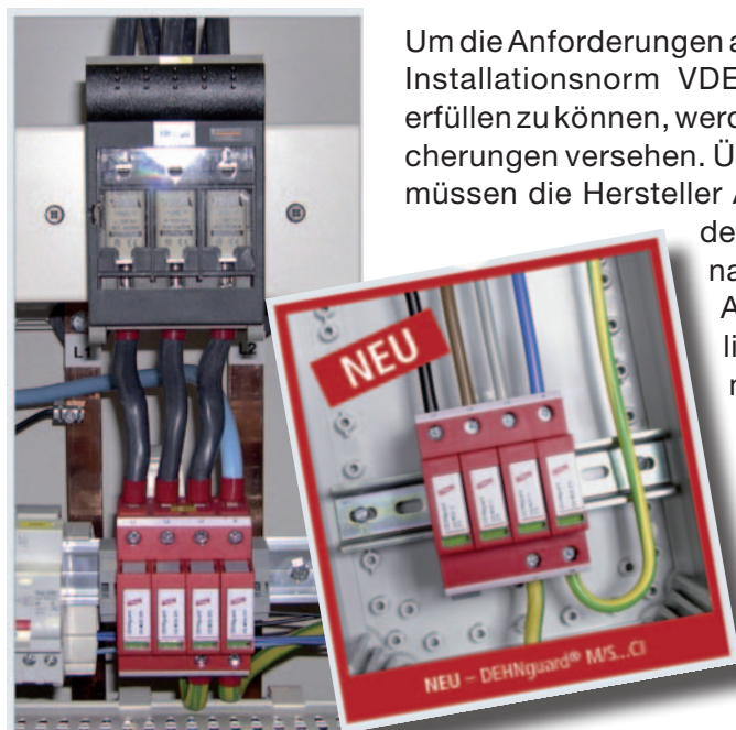
Abb. 1: Deutlich reduzierter Platzbedarf – Vergleich Einbauverhältnisse herkömmlicher Typ 2-Ableiter zum DEHNguard® M/S Cj 51
