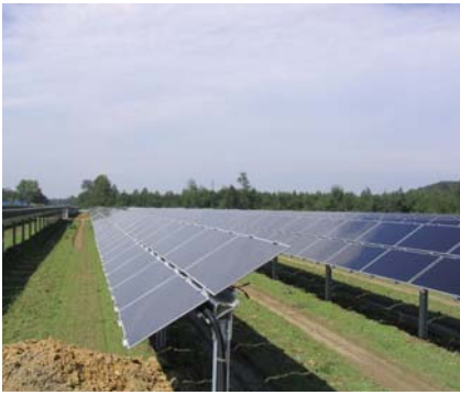
Abb.4 Design der Unterkonstruktion 2005 (zwei Module quer übereinander)
