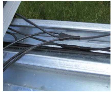
Abb.6 Neue Fertig-DC-Kabel für die Strang-Verkabelung
