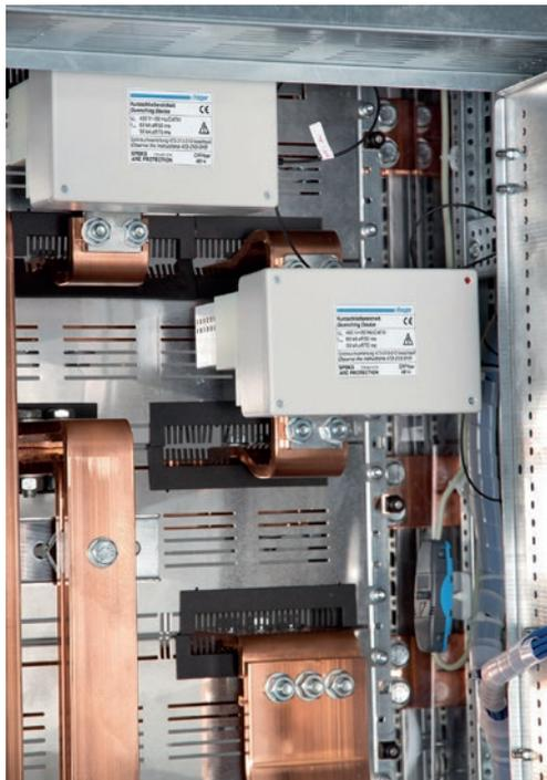
Abb.3: Die Kurzschliebereinheit löscht den Störlichtbogen in nur 2,6 Millisekunden.
