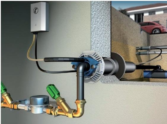
Abb. 5: Einsparten-Hauseinführung für Wasser, Telekom und Lichtwellenleiter (LWL)
