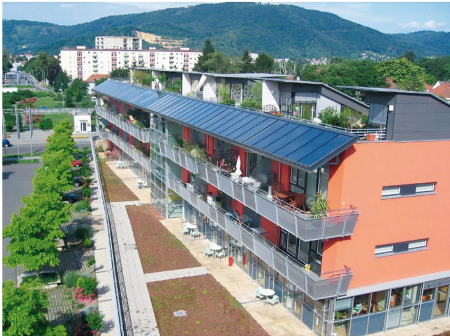
Abb.3: Solarthermische Anlage auf einem Mehrfamilienhaus in Süddeutschland
