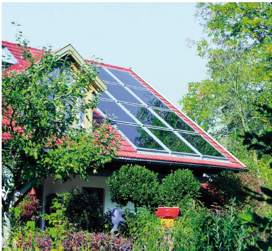
*Dachintegrierte Kollektoren auf einem Haus in Deutschland*
