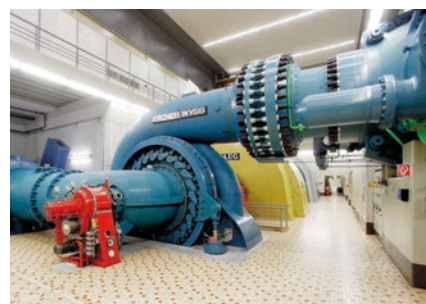
Abb. 2: Pumpspeicherkraftwerk Bad Säckingen
