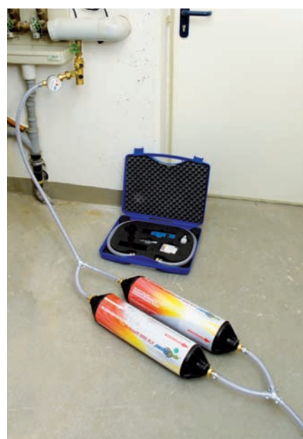
Abb.6: „Permasoft“ entsalzt und alkalisier Heizungsfüllwasser in einem Schritt
