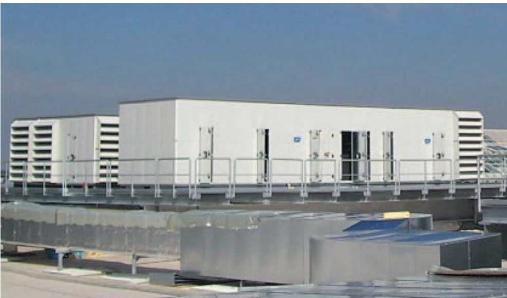
Abb. 1 Zusammensetzung eines modernen RLT-Komplettgerätes mit integrierter Direktkältetechnik (Foto robatherm)
