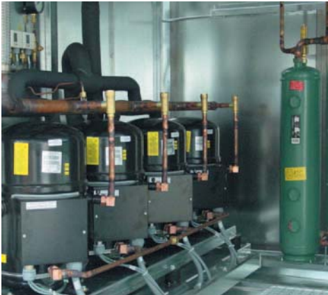
Abb. 4 In einem RLT-Zentralgerät integrierte Direktkältetechnik
