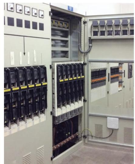
*In der Schaltschranktüre integrierte Antenne zur Übertragung von Energie und Messdaten zum RFID Temperatur Transponder*
