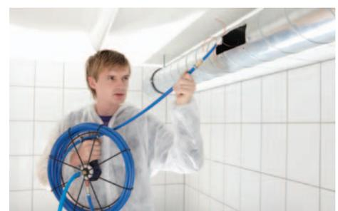
Abb.6: Reinigen mit der Drucklufthaspel
