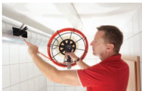
Abb.4: Reinigung einer Lüftungsanlage mit der Wöhler H 420 Handkehrhaspel
