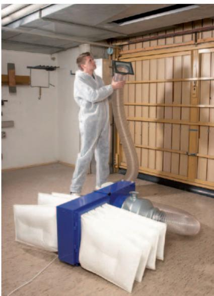
Abb.7: Mit einer Staubfalle wird der abgeschlagene Schmutz aus den Rohren abgesaugt
