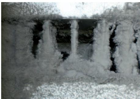
Abb.2: Eine verschmutzte Lüftungsanlage
