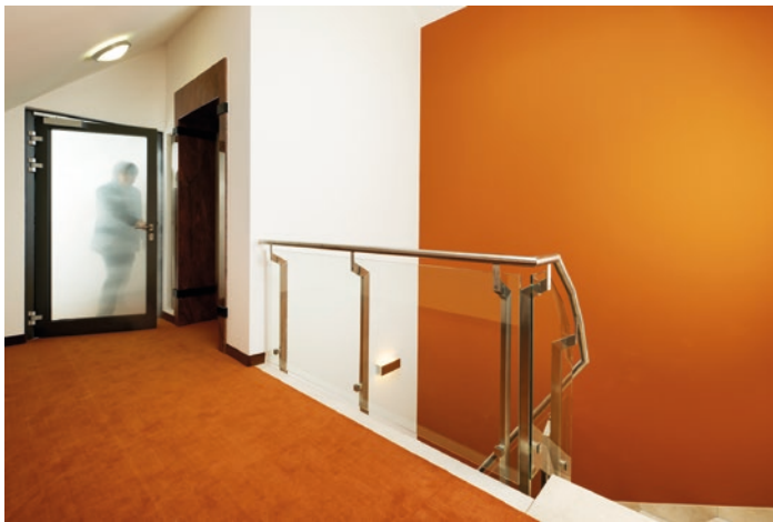
Der Überdruck in Sicherheitstreppehäusern muss exakt gemäß der Norm geregelt sein. Nur so ist die Eigenrettung möglich und der Rauchübertritt wird verhindert.
