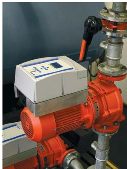
Art bei Frequenzumrichtern bislang nicht vorhanden waren. Hervorzuheben ist hier die in der Software hinterlegte Pumpenkennlinie, die es ermöglicht, den hydraulischen Arbeitspunkt der Pumpe zu bestimmen und eine Aussage zu treffen, ob diese in einem günstigen Kennfeldbereich betrieben wird. Ist dies nicht der Fall, wird eine Meldung über die Klemmleiste, die Anzeige oder den Feldbus abgesetzt.
