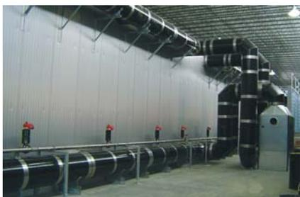
und Rohrleitungen. Je nach Aufgabenstellung können die Segmente mit einer chemikalienfesten Deckschicht aus GFK, auf Wunsch auch in Edelstahl oder Alu, ausgeführt werden; Erfüllung der Brandschutzklassen B2 und B1 auf Anfrage. Zum Zubehörprogramm gehören unter anderem Bögen, T- und Y-Stücke, Diffusoren, Anströmdüsen sowie Verschlussklappen.
