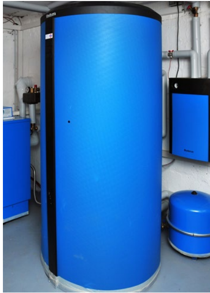
Abb.5: Im Wärmespeicher kann der Power-to-Heat-Strom als Wärme für Wasser oder Heizung gespeichert und bedarfsgerecht bereitgestellt werden.
