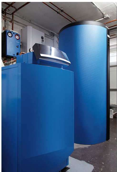
Abb. 1: Das Berliner Referenzobjekt verfügt, neben Power-to-Heat-Elektroheizer und PV-Anlage, über ein modulierendes Öl-Brennwert-Heizgerät mit 5 bis 15 kW Leistung
