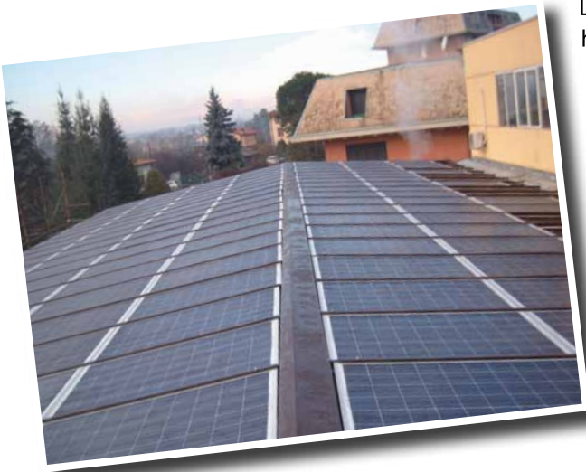
Abb. 1: Dachneigung 10°, Nord-Südanlage
