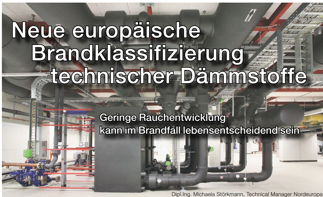
Abb. 1: Isolierung mit flexiblen Elastomer-Dämmstoffen von Rohrleitungen, Behältern, Armaturen und weiteren Anlageteilen
