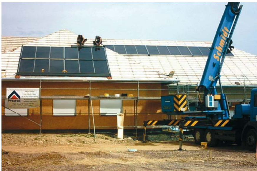
Abb.2 Montage der vormontierten Kollektorflächen mit Hilfe eines Kranes
