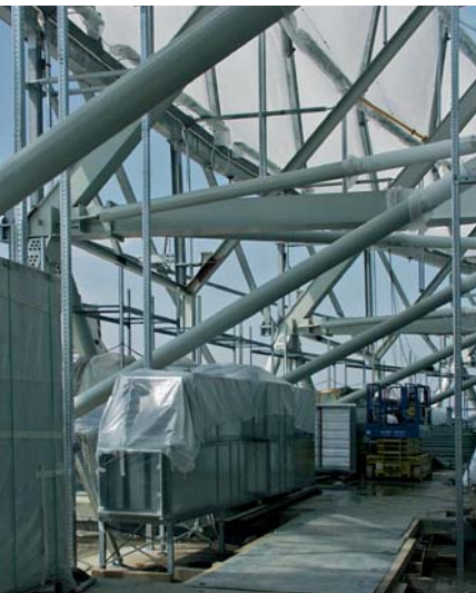
Schutz der Geräte vor Witterung durch Membranhülle
