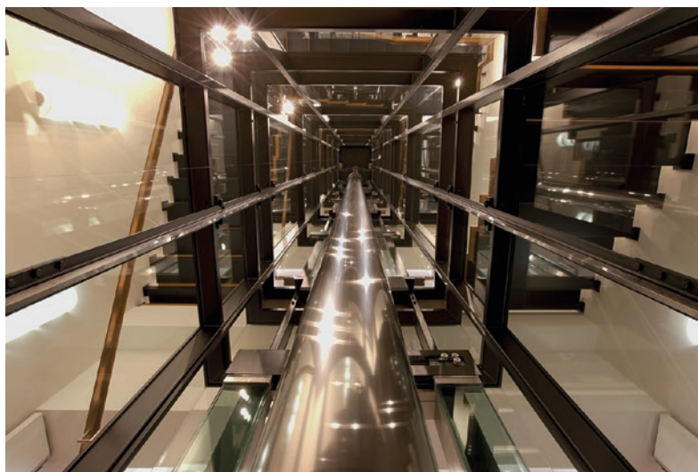
Abb. 2: In frequenz geregelter Ausführung sind hydraulisch angetriebene Aufzüge leise, zuverlässig und energieeffizient.
