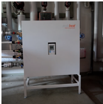
Abb.3: Frischwasserstationen (1.300 l/Std. bis 12.360 l/Std.) können zusammen mit einer mobilen Heizzentrale (100 bis 6.000 kW) schnell wieder für warmes Wasser sorgen. Meist werden sie bei Defekten oder Sanierungsarbeiten an der Heizanlage eingesetzt, kommen aber auch bei thermischer Desinfektion zum Einsatz.
