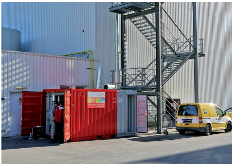
Abb.2: Das Studio 9 in der Bavaria Filmstadt beeindruckt durch seine Größe. Im Vordergrund befindet sich die mobile Heizzentrale MH 600C, die die Umrüstung der Energieversorgung unterstützt.
