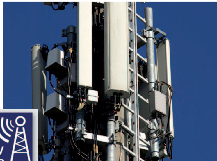
Abb. 1: Sendemast als Störquelle im Bereich EMV
