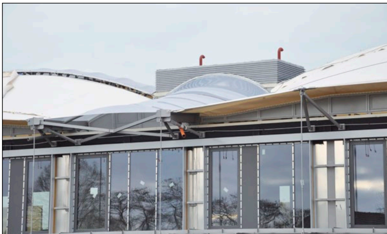
Abb.3: Durch die Wahl des Membran-Grundmaterials wird die Lichttransmission vorgewählt. Zusätzlich lassen sich die Membranen bedrucken.
