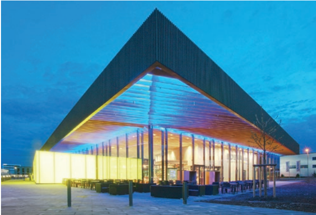
Abb. 5: Das Beleuchtungskonzept des E-centers Gaimersheim passt sich automatisch an die jeweilig vorhandene Menge an Tageslicht an.
