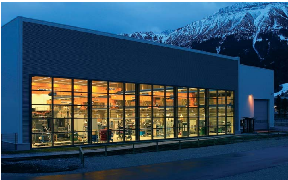
Die neue Montagehalle „F 1“ von Deckel Maho in Pfronten/Allgäu mit thermisch-aktiver Pfosten-Riegel-Glasfassade
