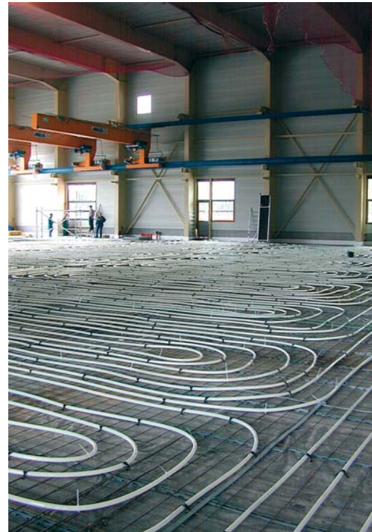
Die Rohre der thermisch aktivierten Bodenplatte liegen direkt auf der Sauberkeitsschicht
