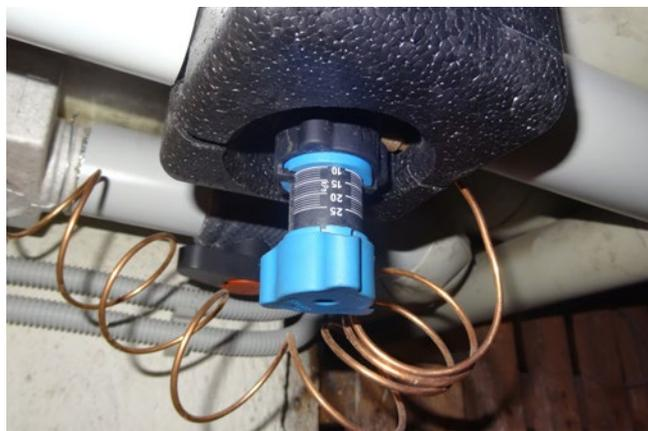
Die gut ablesbare Einstellskala wird ohne Werkzeug mit der Hand auf den gewünschten Differenzdruck eingestellt und arretiert. Die Einstellung bleibt auch bei Nutzung der Spülfunktion erhalten, bei der das Ventil zum Befüllen oder Spülen vorübergehend komplett geöffnet werden kann.
