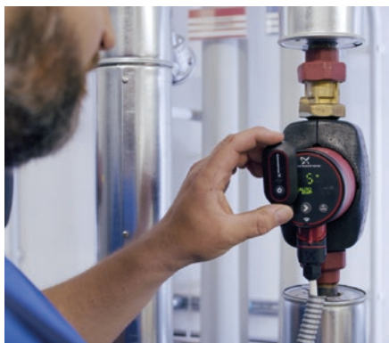
Empfehlung des Herstellers: die Regelungsart AUTOADAPT an der Pumpe einstellen
