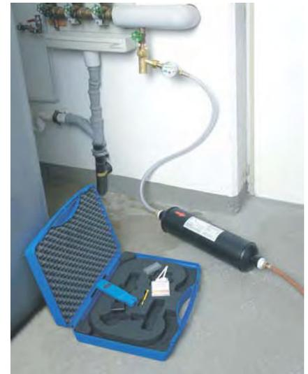
Abb.3 Einfache Befüllung gemäß EN 1717
