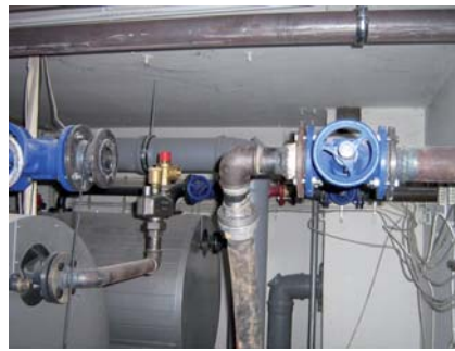
Abb.3 Bauseitiger Einspeisanschluss
