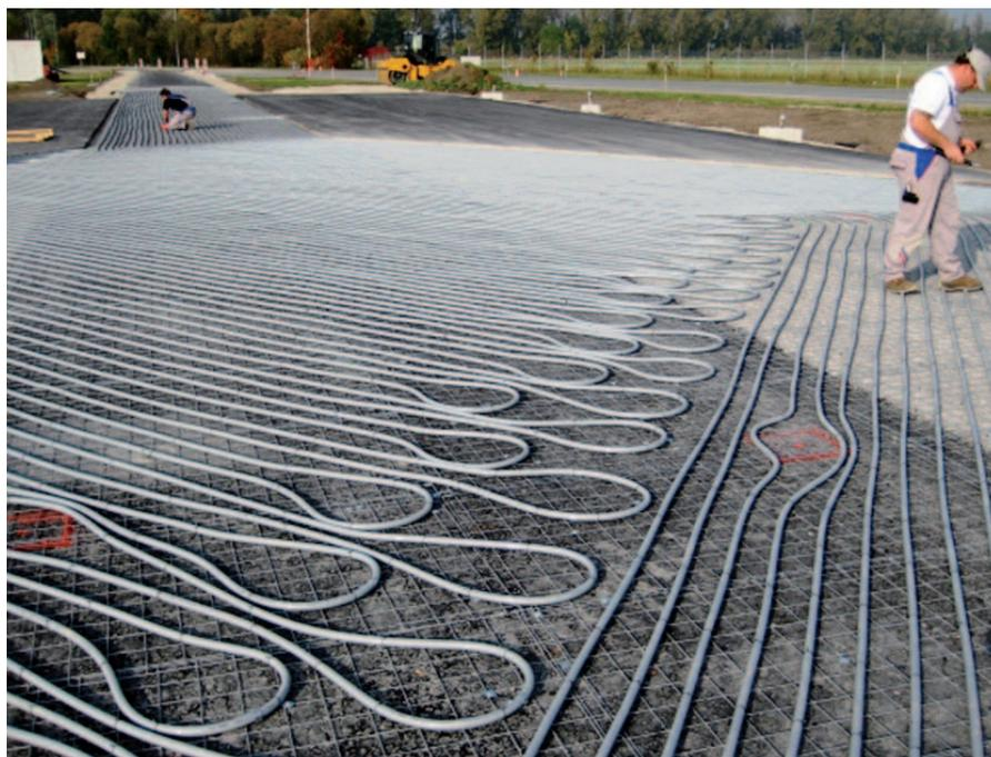
Abb.5: Einbau von RAUGEO stabil in eine Gussasphalt-Deckschicht
