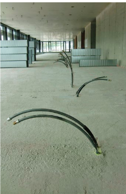
Abb.4: Für die Thermische Bauteilaktivierung (TBA) wurden im abgebildeten Beispiel Heiz- und Kühlrohre aus PE-X in die Deckenkonstruktion integriert.
