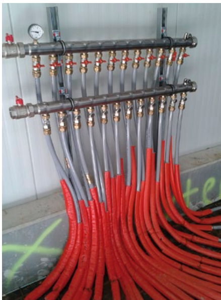
Abb.3: Für die Anwendungsbereiche Industrieflächenheizung und Thermische Bauteilaktivierung führt IVT zusätzlich zu PE-X-Heizrohren bis 25 mm Durchmesser auch großvolumige Heizkreisverteiler im Sortiment.
