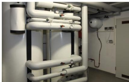
Die Wärme aus der bauseits bereits vorhandenen Solarthermie-Anlage wird zur Vorwärmung des Warmwassers genutzt. Die Nachwärmung erfolgt über einen in Serie geschalteten Hygienespeicher mit Edelstahl-Wellrohr-Wärmeübertrager nach dem Durchlaufprinzip.
