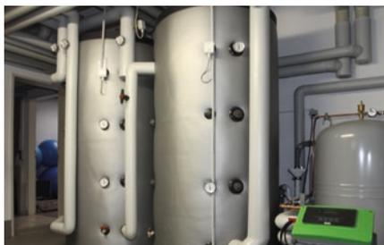
Die Heizwasser-seitigen Pufferspeicher spielen eine wichtige Rolle zur Entkoppelung von Wärmeerzeugung und Wärmeabnahme. Sie sind ein wichtiges Instrument zur Verlängerung der BHKW-Laufzeit und zur Bereitstellung hoher Heizleistungen für die Frischwasserstation.
