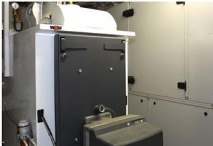
Der Öl-Heizkessel MKS dient zur Abdeckung von Spitzenlasten und als Reserve und wird aus den vorhandenen Heizöltanks gespeist.
