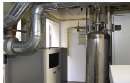
Der hohe Modulationsgrad des Gas-Brennwertheizkessels unterstützt das Speichermanagement, verlängert die BHKW-Laufzeit und sichert eine hohe Warmwasserleistung. Der Öl-Heizkessel geht nur bei absoluten Lastspitzen oder im Notfall in Betrieb.
