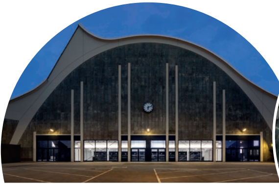
Abb.1: Das Mehr! Theater in Hamburg ist in den Großmarkt integriert und sticht durch die besondere Bogen-Architektur und die Raumhöhe von 20 Metern hervor.
