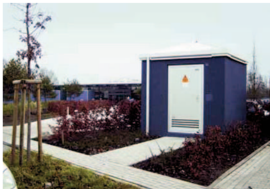
Mittelspannungsstation
