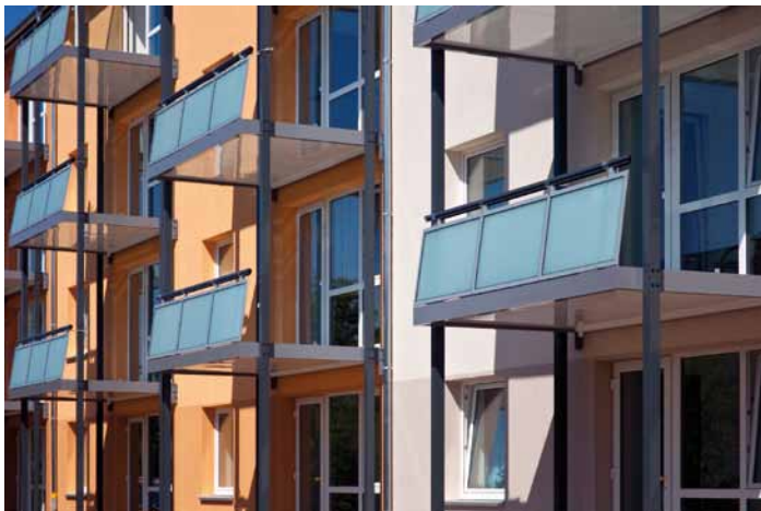
Abb.2: Die DIN wie auch die EnEV spiegeln wider, dass aktiver Feuchte- und Schimmelschutz nach energetischer Sanierung nur über mechanische Lüftung sichergestellt werden kann.
