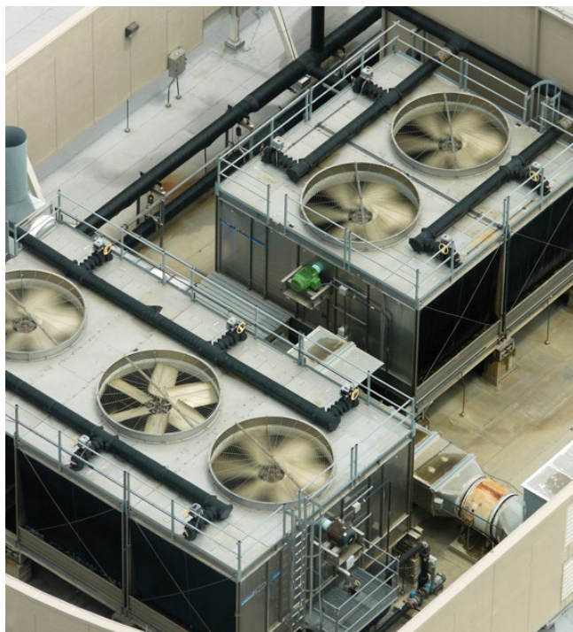
In Kälteanlagen sind Frostschutzthermostate unverzichtbare Bestandteile
