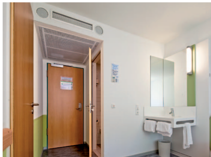
Abb.3: Niedriger Geräuschpegel durch einen bauseitigen Filter in den Deckeneinbaugeräten mit Kanalschluss
