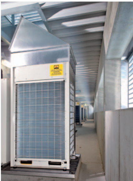
Abb.1 Für einen besseren Schallschutz wurde über jedes VRV System eine Ausblasvorrichtung aus Edelstahl montiert.
