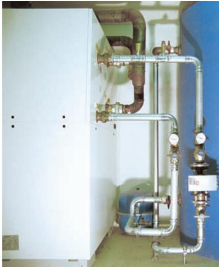
Abb.3: Der Gebäudekomplex wird zu 30% mit einer Wasser/Wasser-Wärmepumpe beheizt. Als Wärmequelle nutzt die Wärmepumpe einen unterirdischen Grundwasserlauf, der durch das Grundstück fließt. Das Grundwasser wird in einem siphonartigen Schacht gefasst und der Wärmepumpe zugeführt.
