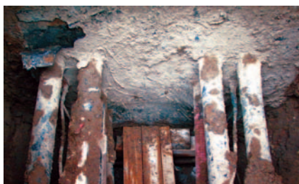
Abb. 1 Dickbeschichtung an den Leitungen
