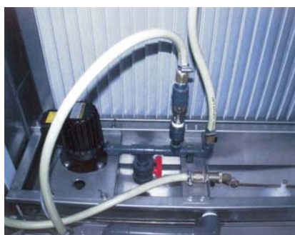
Abb.11 Kontaktbefeuchter von der Druckseite aus gesehen
