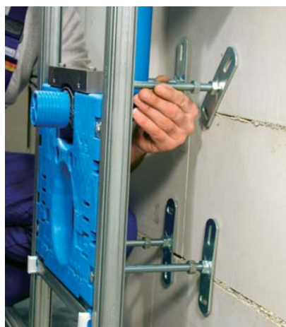
Abb.4 Eine zusätzliche Abstützung der Sanitärelemente sorgt für Stabilität
