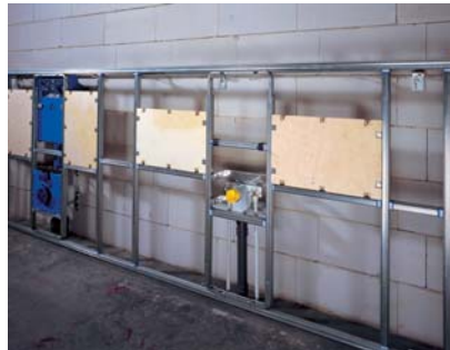
Abb.2 Trockenbausysteme, wie das Montagesystem FRIAPLAN, ermöglichen die schnelle und saubere Montage sowie die individuelle Gestaltung von barrierefreien Sanitäräumen
