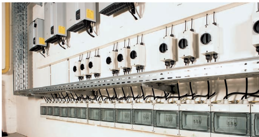
Abb.3: Praxisbeispiel Überspannungsschutz
