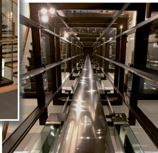
Abb.2: Gleichgültig, ob Seil- oder Hydraulikaufzug: Der VLT® LD 302 kann beide Arten steuern. Und das ohne zusätzliche Schütze für die Sicherheit, wie der TÜV-Nord bescheinigt.
