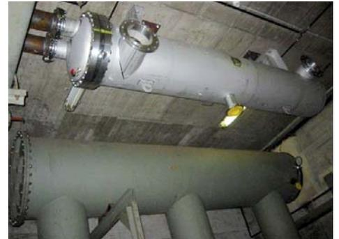
Abb.1 Herzstück der Wärmerückgewinnung: Der an der Decke montierte Edelstahl-Rohrbündelwärmetauscher vor dem Anschluss an die Dampfleitung
